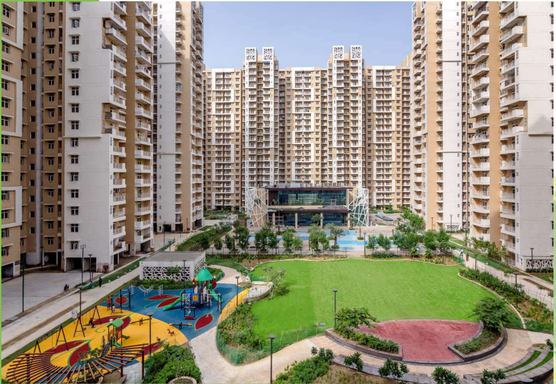
Actual Site image
