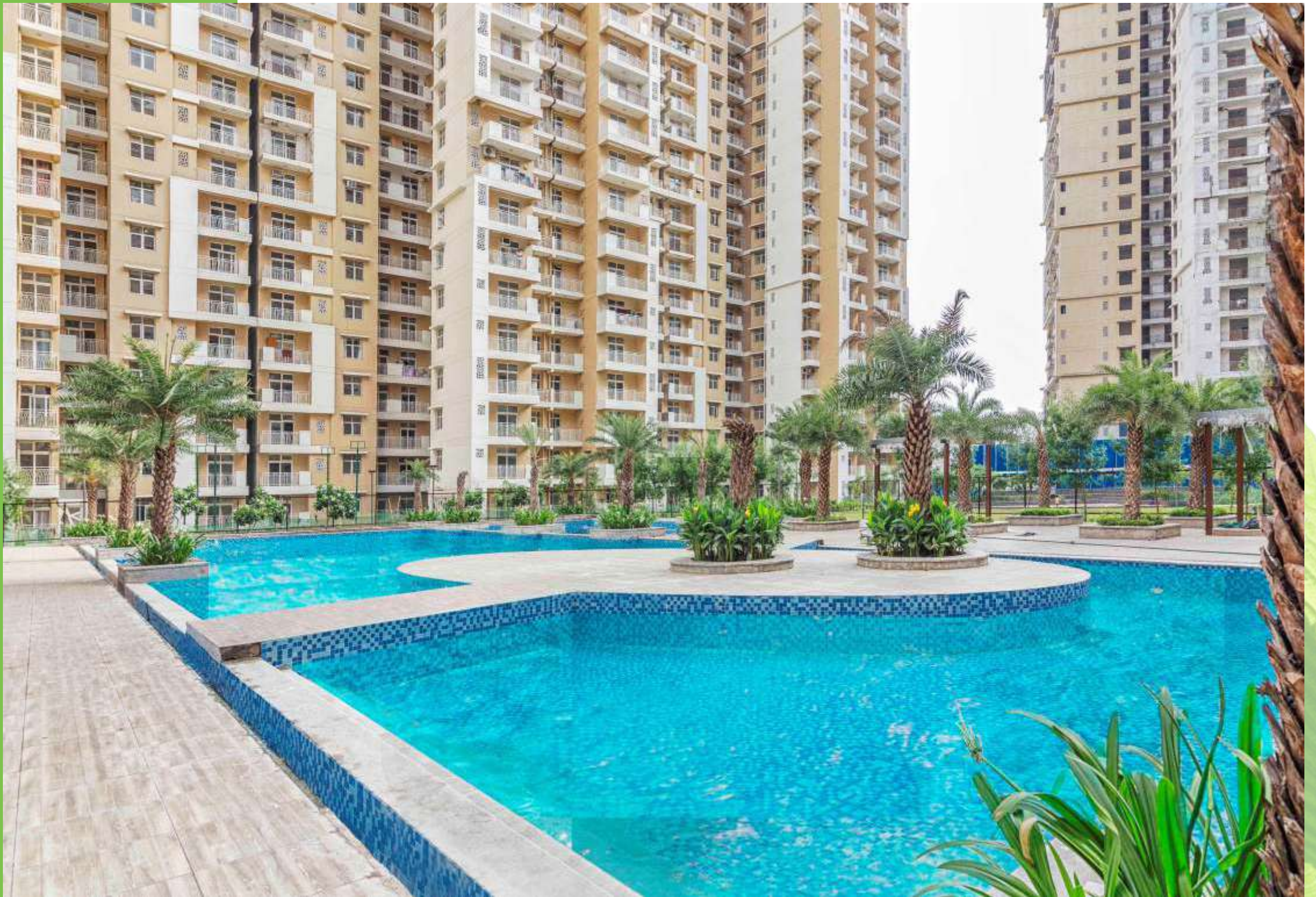
Actual Site image
